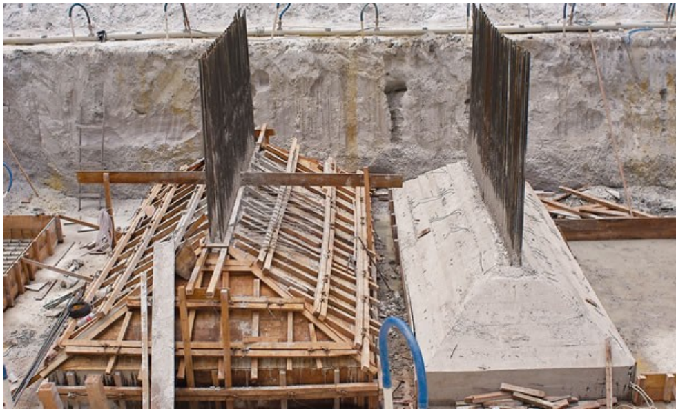
Figura 05_ Foto de execução de Sapatas.
