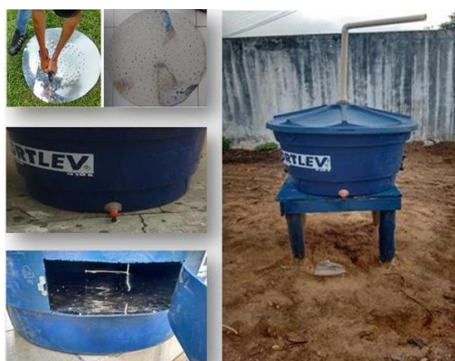
Figura 1. Etapas de construção e instalação do biodecompositor.
