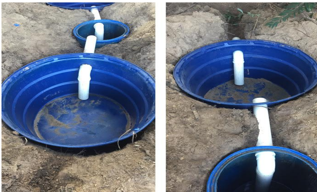
Figura 02: Instalação da tubulação nos recipientes
