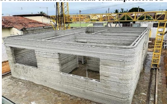
Figura 1: Primeira casa construída com impressora 3D no Brasil
