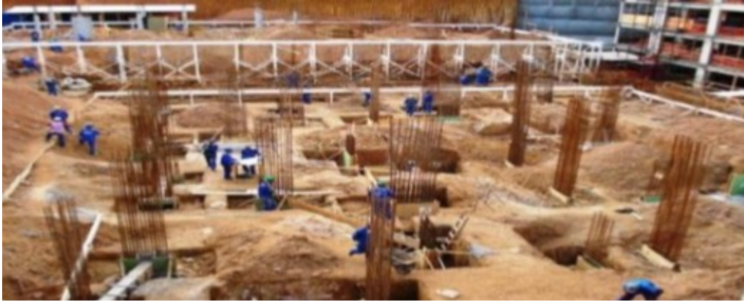
Imagem de fundação bem-sucedida. Fonte: fundaçõessuperficiais
