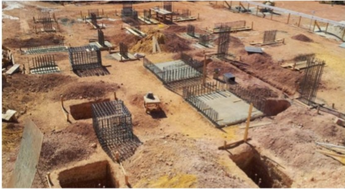
Imagem de falhas na fundação. Fonte: fundaçõessuperficiais
