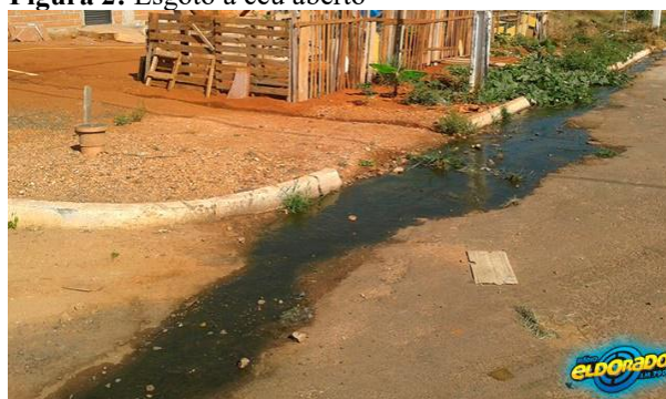
Figura 2: Esgoto a céu aberto
