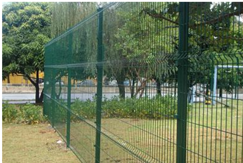
Figura 13: Grades para fechamento de área
